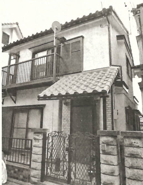
耐震改修工事を行った2階建ての住宅 (東京都大田区、望月工務店提供) ※:画像は一部修整しています
