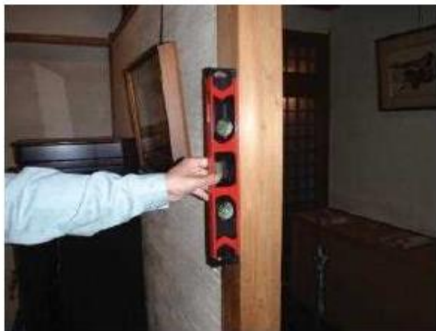
水平器による柱の傾きの計測
