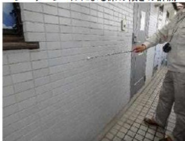
打診棒によるタイルの浮きの調査
