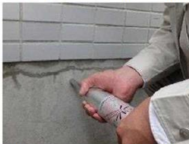
リバウンドハンマーを用いたコンクリートの 圧縮強度の測定 ※大規模建築物の場合
