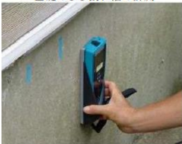
基礎配筋の調査 ※劣化事象・有りの場合
