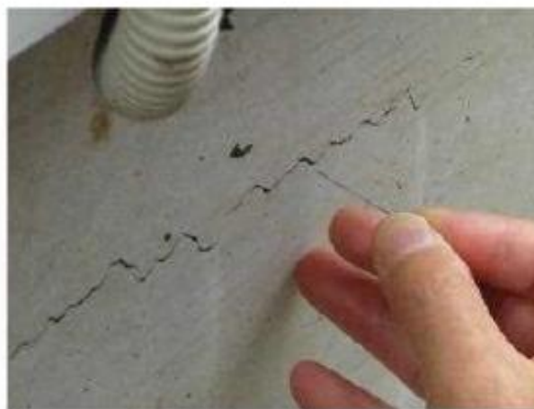
ピアノ線によるひび割れ深さの計測
