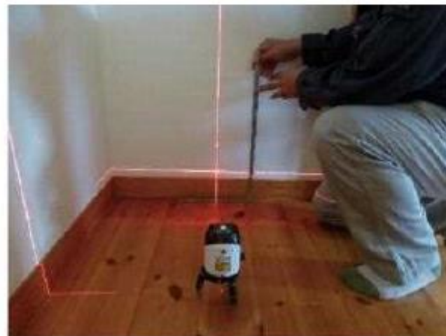
レーザーレベルによる床の傾きの計測
